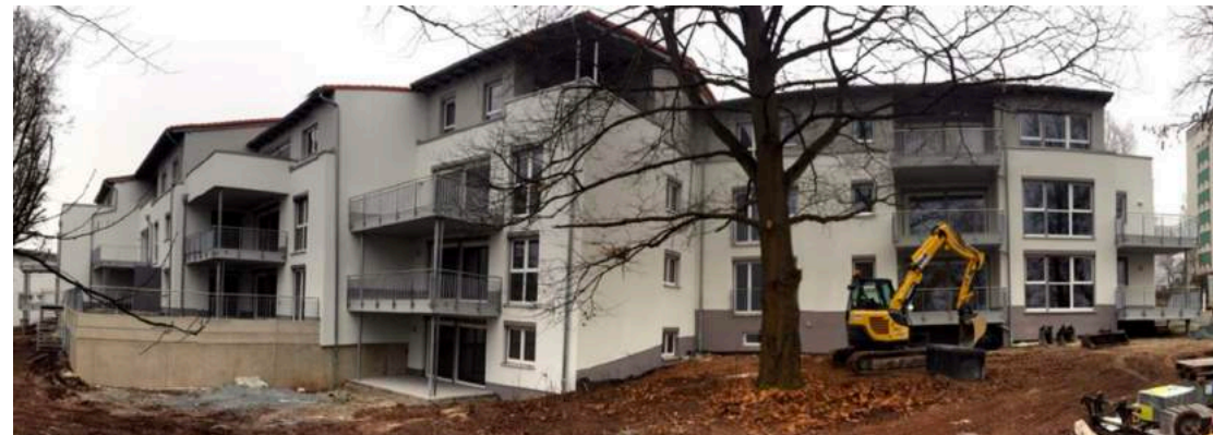
Coburg | Neubau von einer Wohnanlage mit 25 Wohneinheiten und einer Tiefgarage
